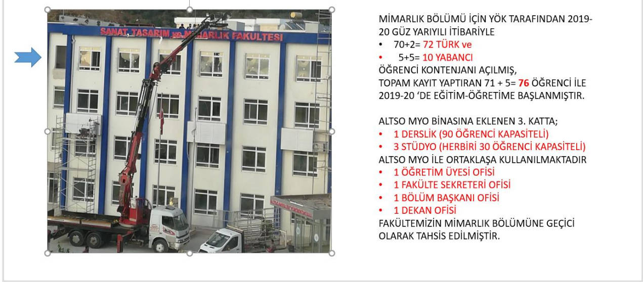
Şekil 3.6. Sanat, Tasarım ve Mimarlık Fakültesine Geçici Olarak Tahsis Edilen ALTSO MYO Binası 3. Katında Yer Alan Mahaller (Bina Bazında)
